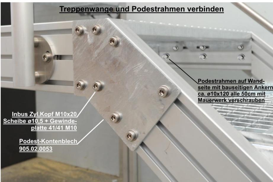
Vor der Montage des Podestes Gewindeplatten M10 in die passende Nut der Alu-Profilwange bzw. des Podestrahmen einfädeln.
