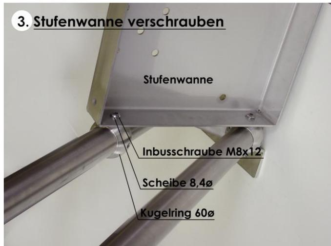
Bei einer größeren Stufenzahl (ab ca. 10 Stufen) sind Stufenwannen mit seitlichen Verstärkungsblechen in der Lieferung enthalten (Abb. 4). Diese werden in Treppenmitte mit 2 zusätzlichen Kugelringen an den Holmrohren befestigt (entsprechend mehr Kugelringe auf Holme auffädeln). Das Verstärkungsblech muß bauseits mit Gewindestangen oder Winkeln an der Wand verankert werden.
