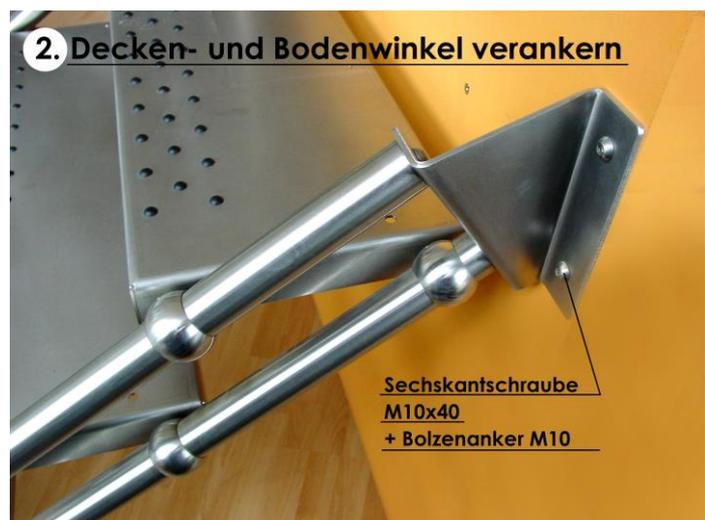
Achtung, die Bolzenanker können nur bei Betonboden eingesetzt werden, bei Estrich oder Holz ggf. passende Verschraubung besorgen. Eine Befestigung des Bodenwinkels auf Beton ist einer Befestigung auf Estrich vorzuziehen!
